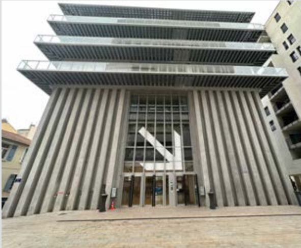
Entrée du bâtiment.
